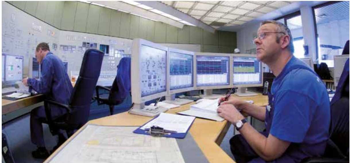
Schaltwarte der Mainova AG
